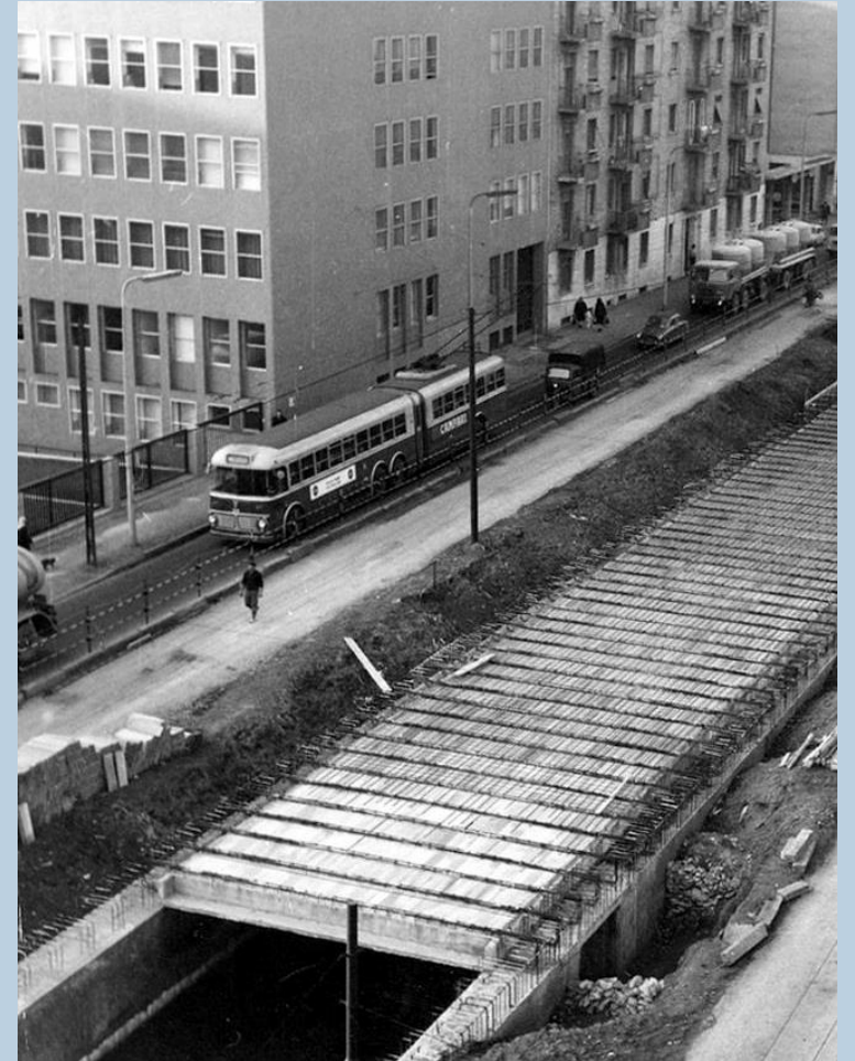
I lavori di copertura dell'Olonia in viale Murillo a Milano
